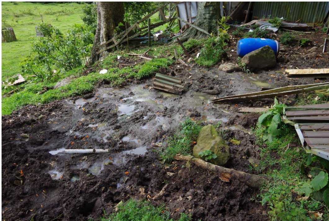
Barreal al costado este de la construcción
