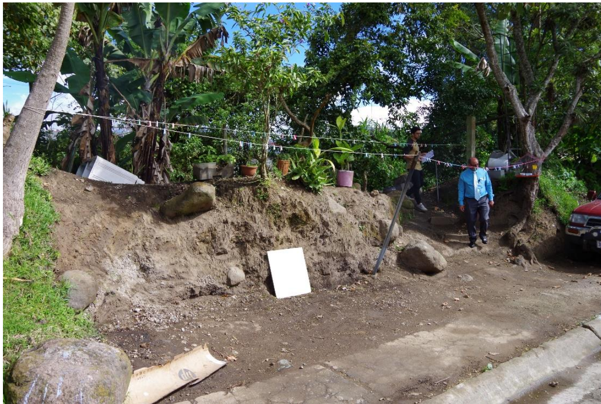
Terreno erosionado para uso particular
