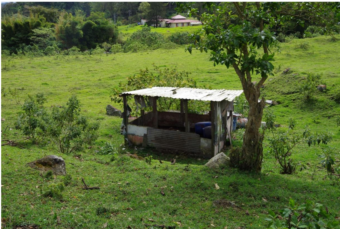
Construcción en material prefabricado
