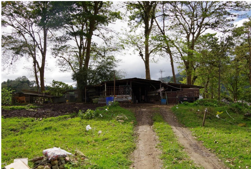
Construcción en el centro de la propiedad sur
