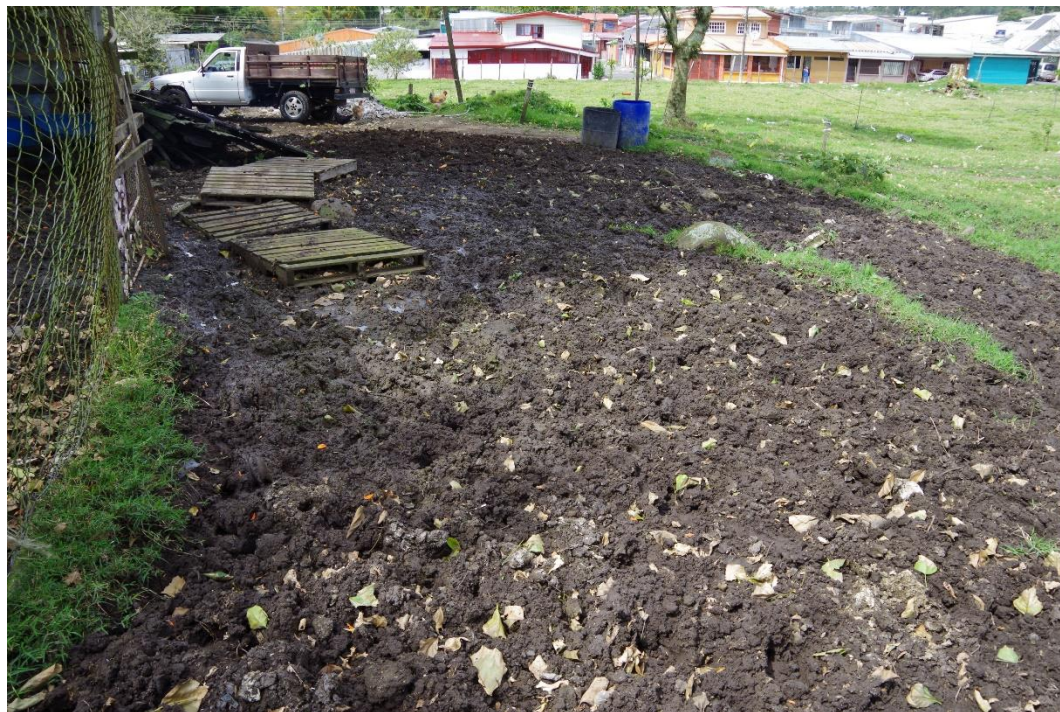
Batidero de tierra al frente de la construcción en el centro del lote sur
